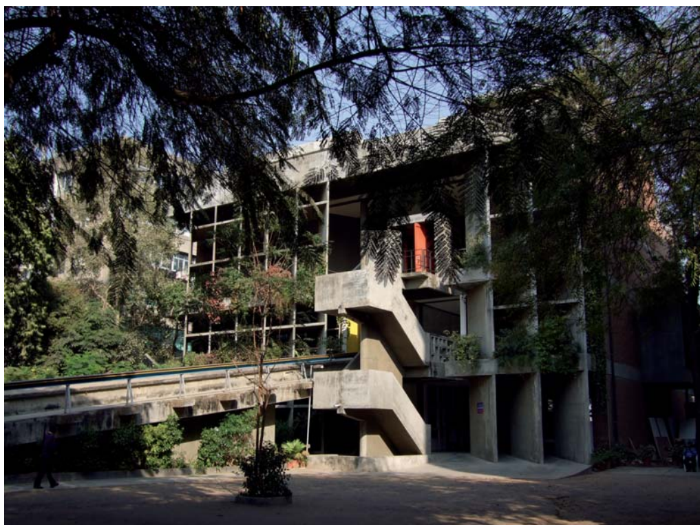
Le Corbusier, Palais des Filateurs (ATMA), Ahmedabad, Inde, photo FLC 2008
